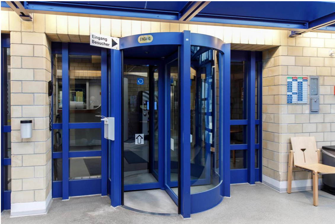
Durch diese Drehtür gelangt man vom Portier zur Sicherheitskontrolle. Foto: Dominique Meienberg
